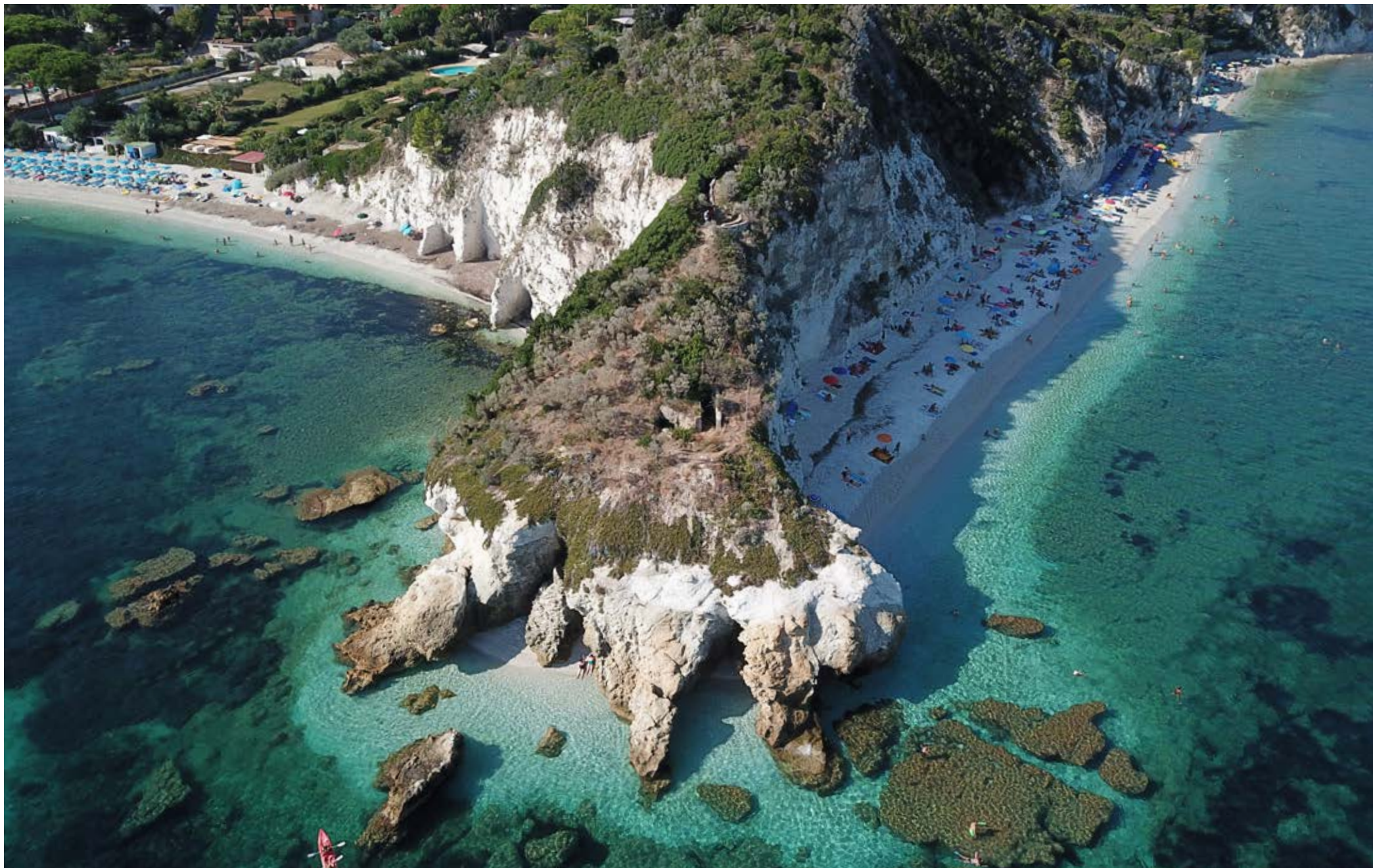
Fig. 231 – Foto della Batteria di Capo Bianco vista dal mare, versante nord. Anno 2023.
