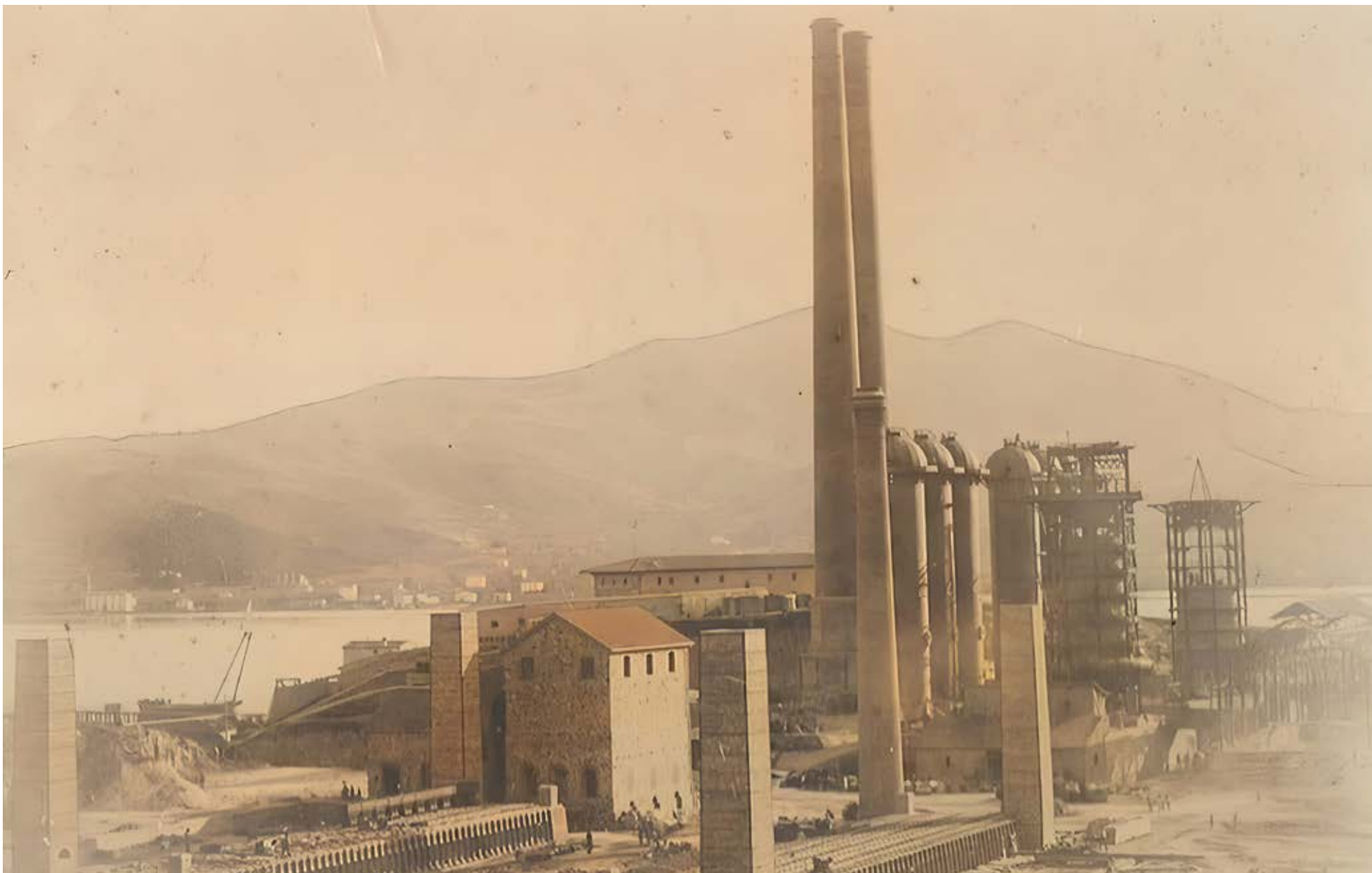
Fig. 81 – La realizzazione degli altoforni va ad occupare l'area in cui sono collocate le Opere del Lazzaretto. È ancora visibile, accanto alle ciminiere, la parte terminale del ricovero in muratura che funge da traversa centrale di Forte Saint Cloud. Anno inizi '900.
