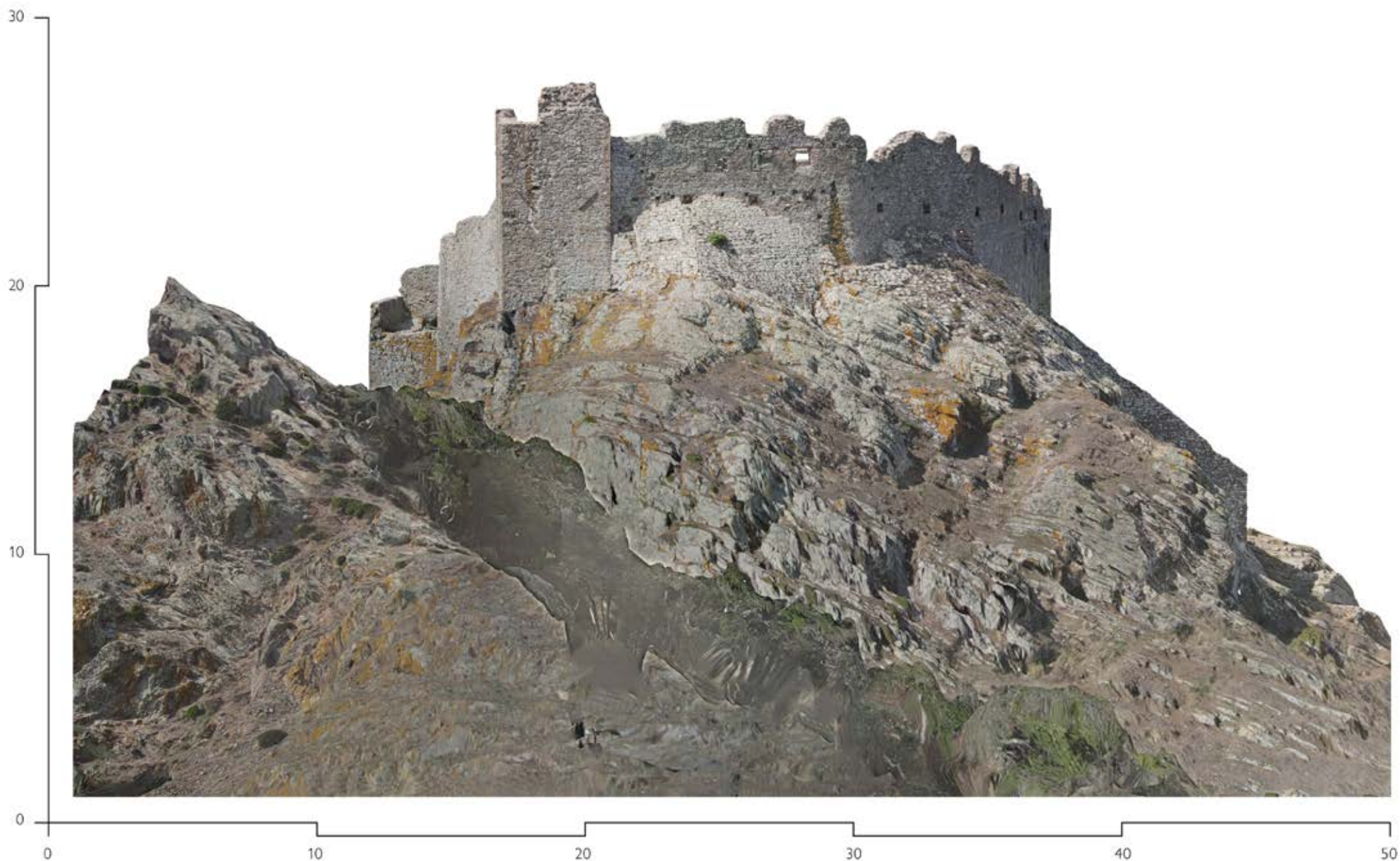
Fig. 41 – Rilievo del 2024. Ortofoto del Prospetto Est, con la torre quadrangolare di periodo medievale. Fortezza del Volterraio.
