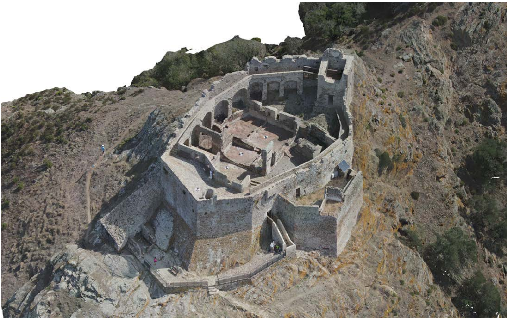
Fig. 46 – Rilievo del 2024. Assonometria vista da Ovest del modello fotogrammetrico della Fortezza del Volterraio.
