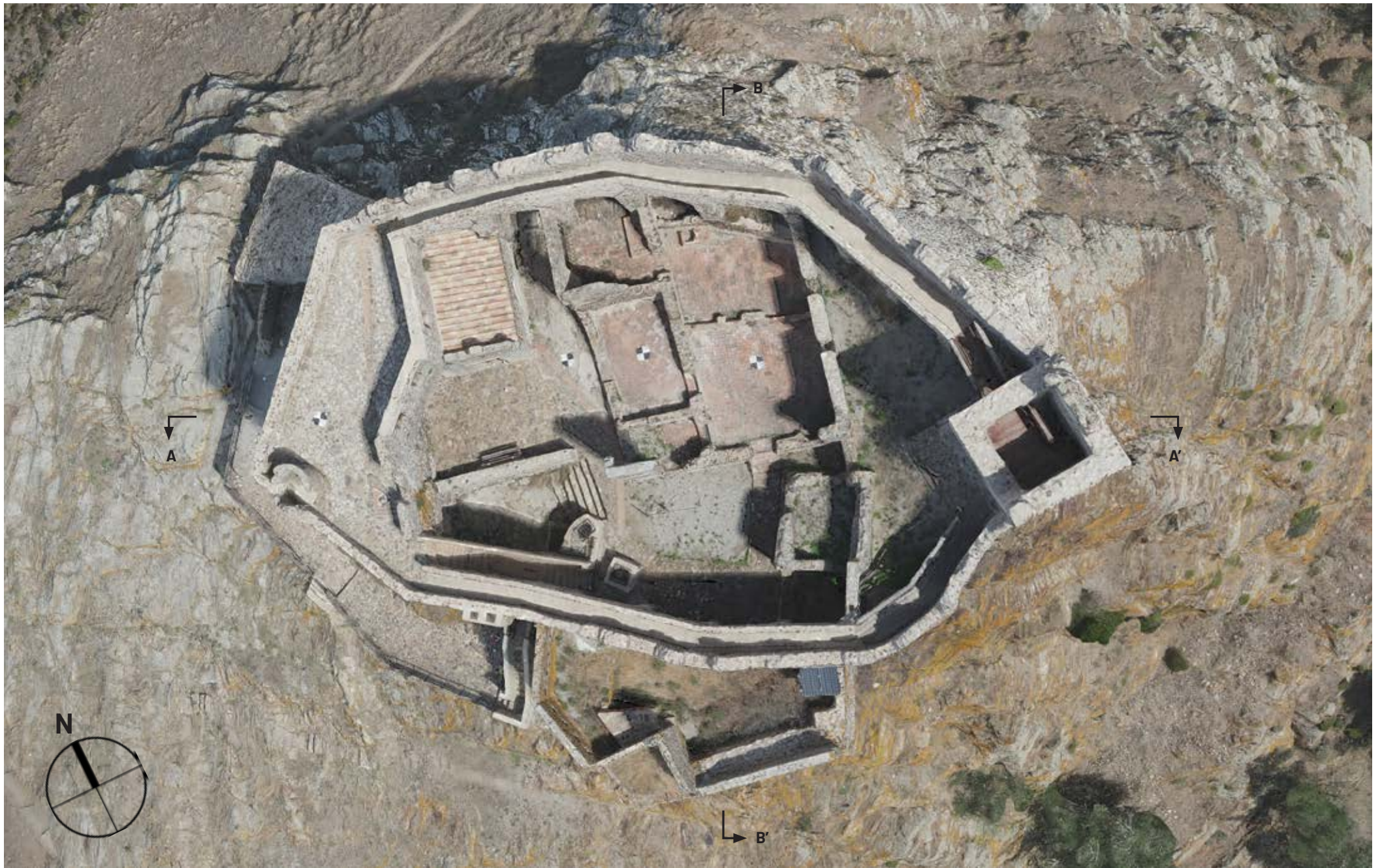
Fig. 37 – Rilievo del 2024. Ortofoto delle coperture della Fortezza del Volterraio.
