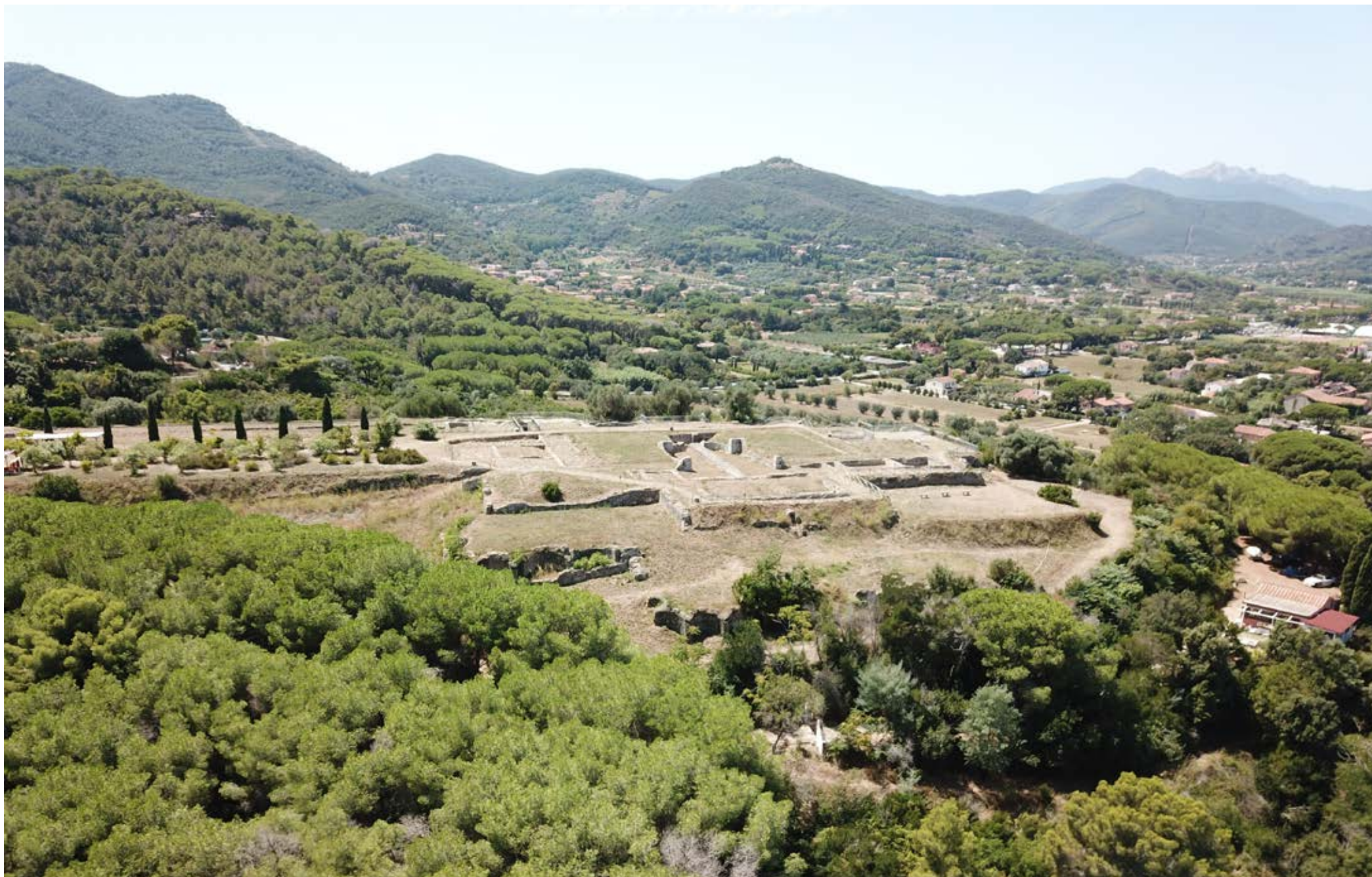
Fig. 224 – La Batteria di Punta delle Grotte è collocata in adiacenza degli scavi della Villa Romana delle Grotte. Anno 2023.
