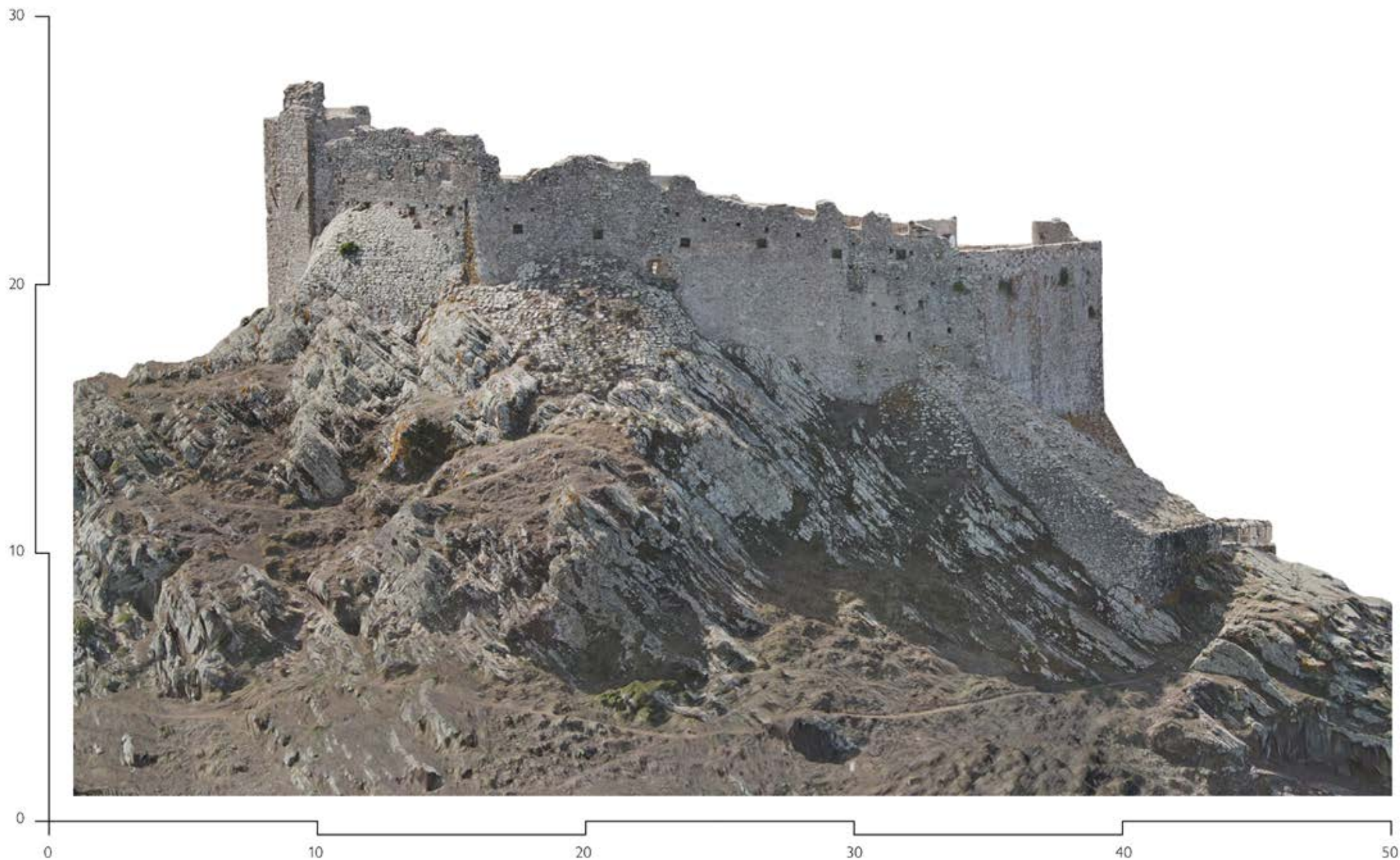
Fig. 40 – Rilievo del 2024. Ortofoto del Prospetto Nord, su uno dei lati a strapiombo. Fortezza del Volterraio.
